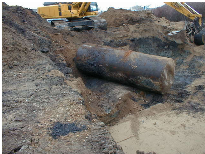
Opgravning af olietank og forurennet jord
