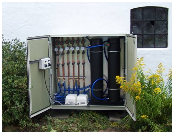
Figur 4: Q&C enhed til ilttilførsel.
