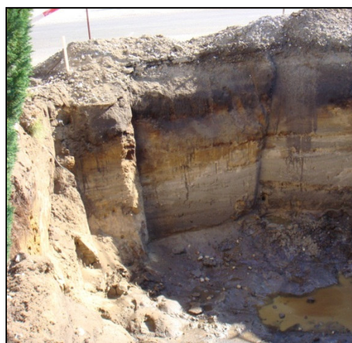
Figur 3.2: Område for gennemførelse af DPD pilottesten i udgravning efter genopfyldning med rent fyldsand.
