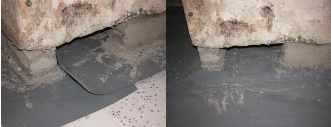
FIGUR 2 - INDSTØBNING AF MEMBRAN I SKILLEVÆG, HHV. FØR OG EFTER SAMMENSVEJSNING
