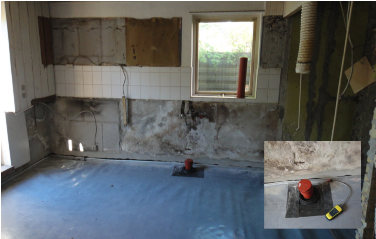
FIGUR 3 - SAMMENSVEJSNINGER AF MEMBRANBANER OG GUMMI-MANCHET OMKRING KØKKENAFLØB
