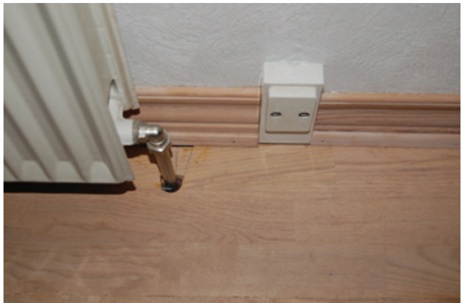
Figur 1. Eksempel på uarmeret betongulv med parket, hvor det i praksis ikke kan ses, om der er revner langs fundament eller omkring rørføringer.
