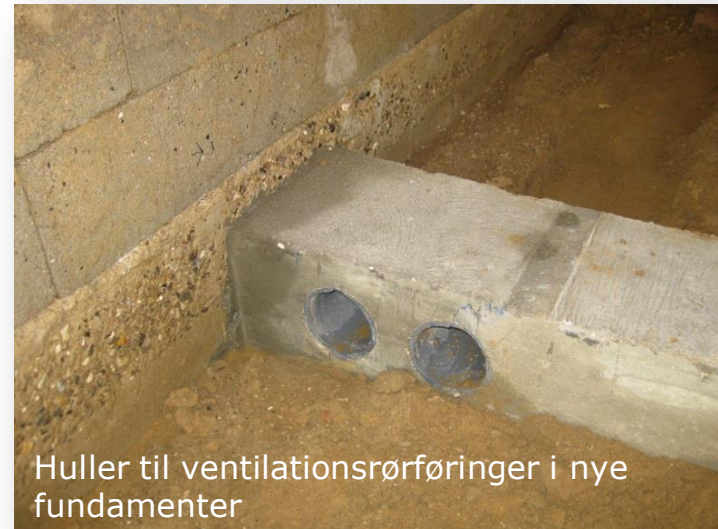
Forskalling til nye fundamenter
